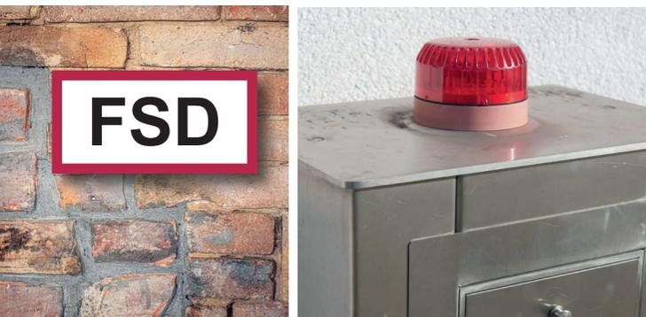
Abbildung 1: Erste Anlaufstelle für die Feuerwehr mit FSD und FSE, häufig gekennzeichnet durch eine rote Blitzleuchte.
