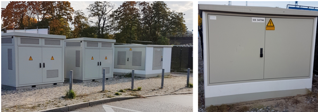
Abb. 9 links.: Schalterhäuschen, rechts.: Transformatorenhäuschen mit ID-Nummer
